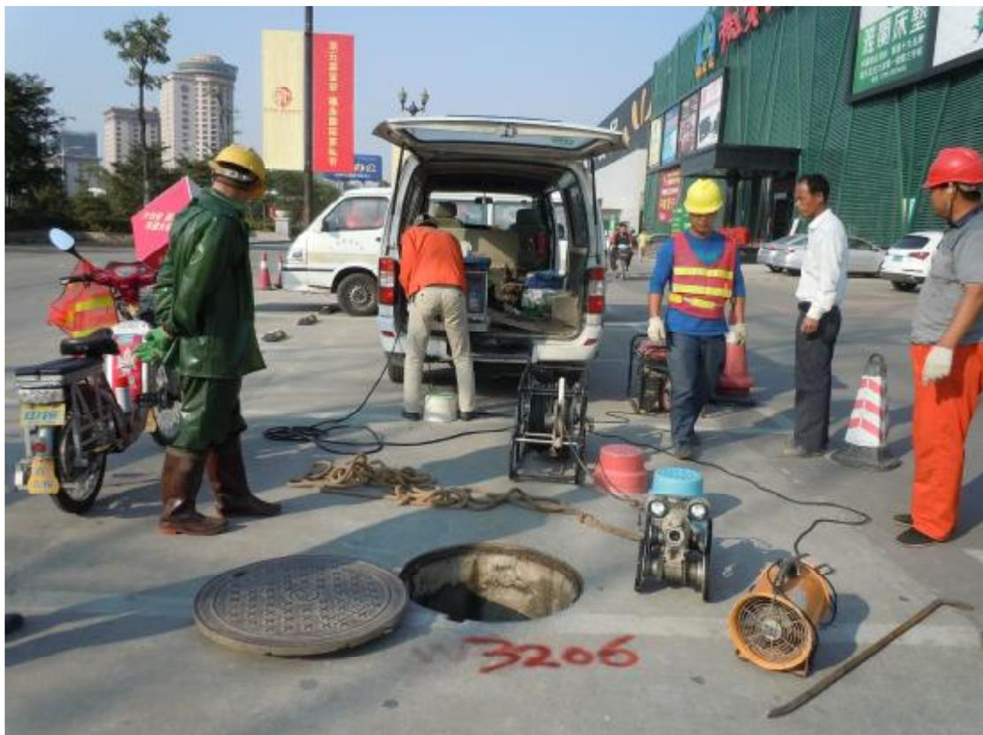
图 5 检测前的准备工作（安全防护，人员、仪器准备）
